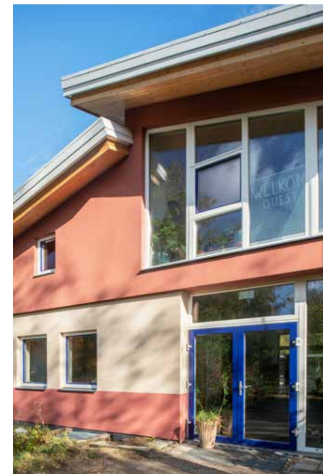
Voor de buitenzijde is er gekozen voor Knauf Aquapanel Cementboard Outdoor en een basismortel weefsellaag met Knauf Aquapanel Exterior Basecoat White. De eindafwerking met de Knauf Conni S sierpleister op siliconen basis in twee kleuren zorgt voor een extra speels effect.
