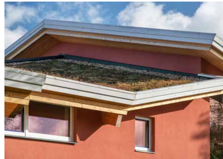
Michaël de Vos (architect en tevens medeoprichter en medegebruiker van de school) heeft zeer bewust de toegepaste materialen gekozen, zoals de houtskeletbouw, leemstuc aan de binnenzijde en het sedumdak.
